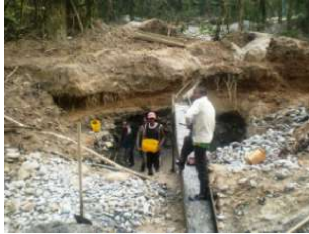
Photo 27 : Le travail dans des puits avec un certain talus, photo GADHOP
