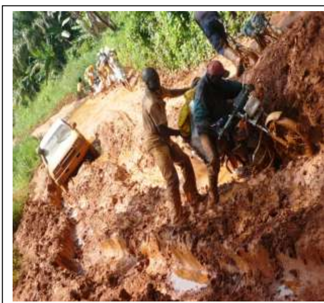
Photo 1: l'état d'une route délabrées vers Manguredjipa, photo GADHOP
